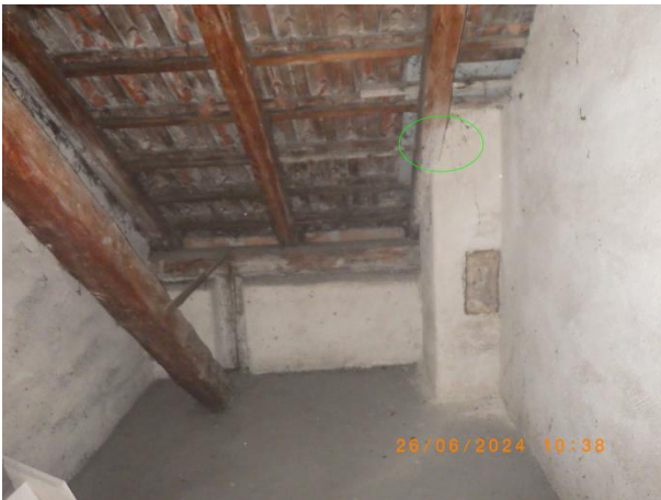
foto 79+ 80 schází 50 mm odstup dřevěné konstrukce od komínového tělesa foto 78
