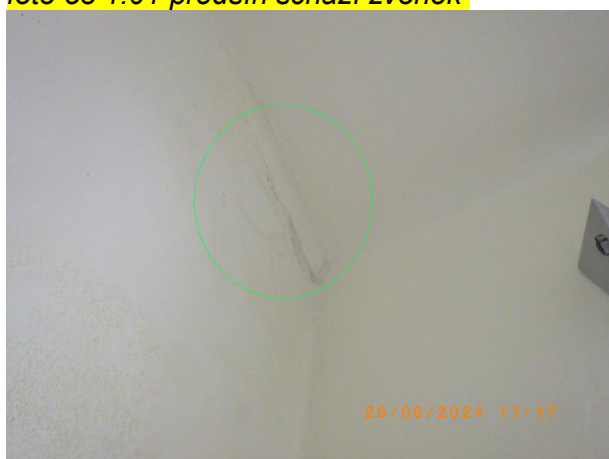
foto 55 1.02 poškození omítky
