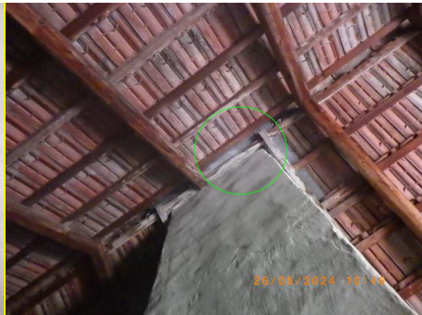
foto 79+ 80 schází 50 mm odstup dřevěné konstrukce od komínového tělesa foto 78
