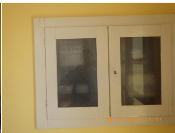
foto 52 1.01 schází označení elektrorozvaděče
