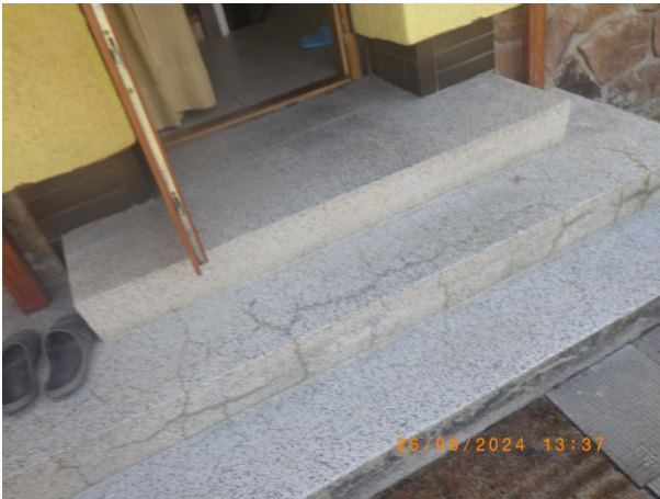
foto 87 poškození povrchu schodiště od trhlin foto 88 schází svislá hydroizolace soklové části zdiva
