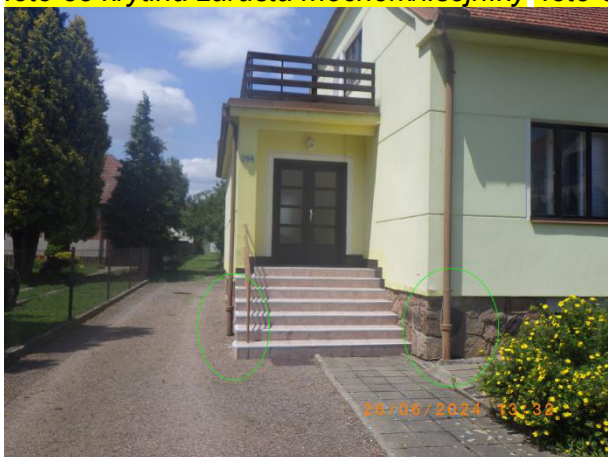
foto 85 schází lapače střešních splavenin foto 86 poškození podbití římsy
