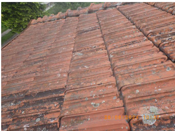
foto 83 krytina zarůstá mechem/lišejníky foto 84 poškození nátěru svodu, schází lapače splavenin
