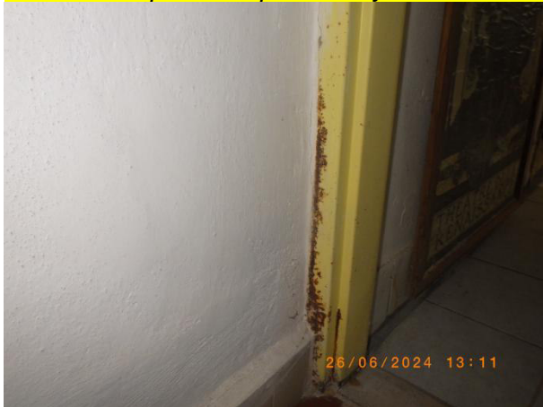
foto 15 +16 0.02 prádelna koroze zárubní + koroze dvířek foto 16
