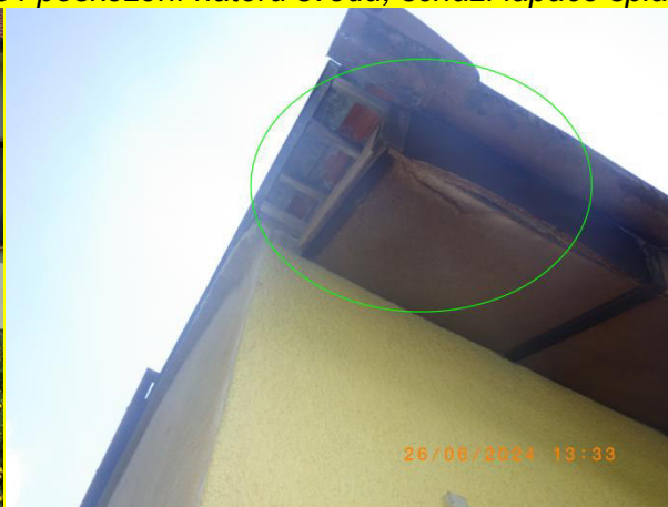
foto 85 schází lapače střešních splavenin foto 86 poškození podbití římsy
