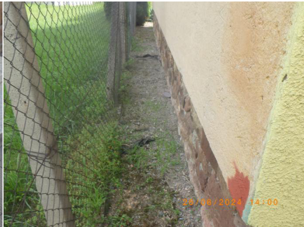
foto 87 poškození povrchu schodiště od trhlin foto 88 schází svislá hydroizolace soklové části zdiva
