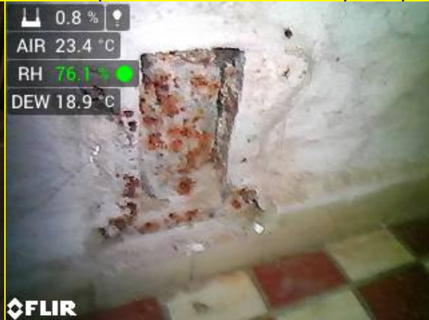
foto 15 +16 0.02 prádelna koroze zárubní + koroze dvířek foto 16
