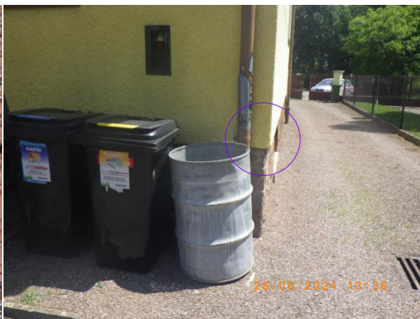
foto 83 krytina zarůstá mechem/lišejníky foto 84 poškození nátěru svodu, schází lapače splavenin
